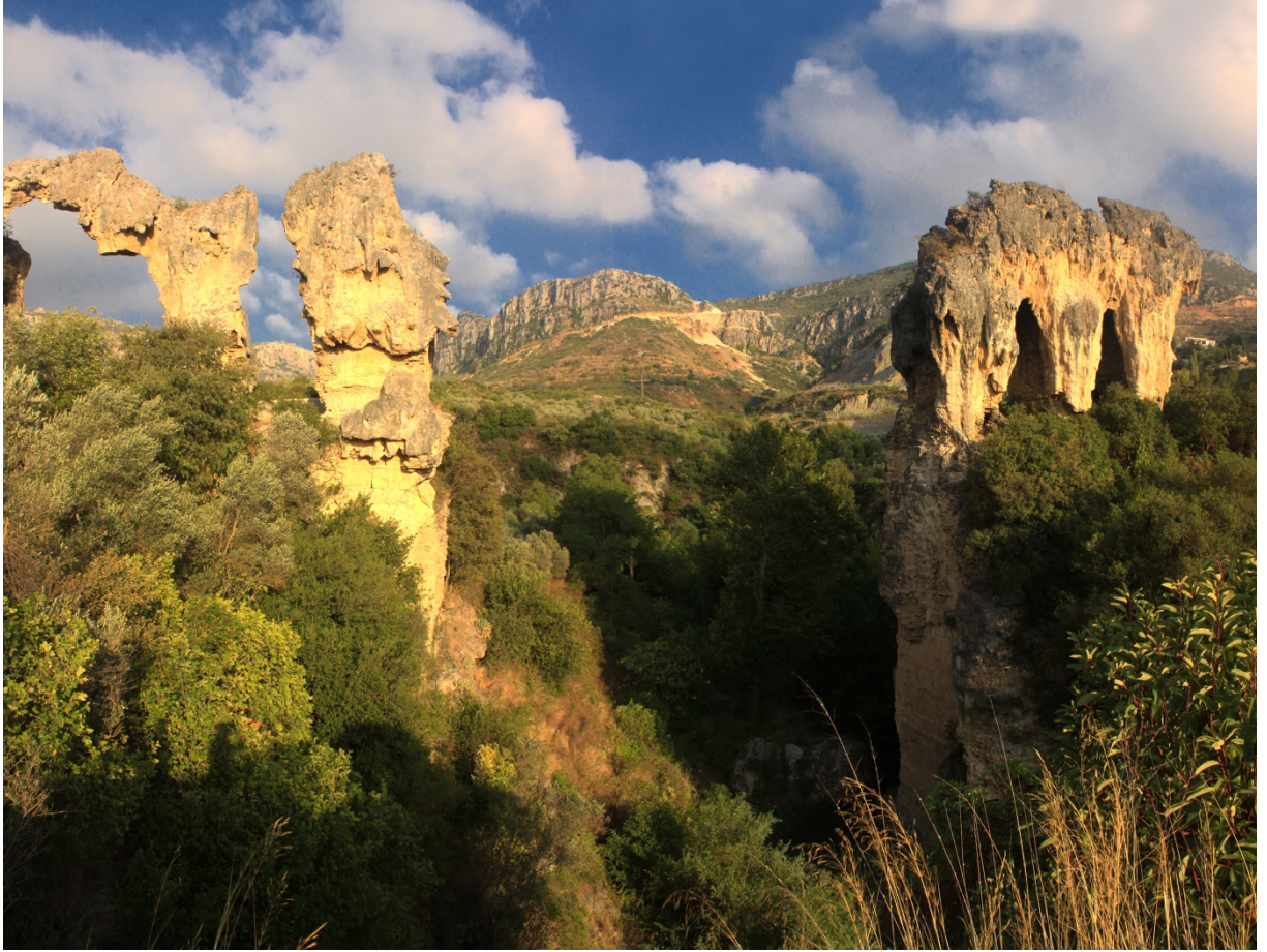
Fotoğraf 3. Kantra Su Köprüsü Kalıntıları
