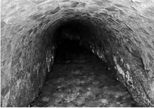
Oygu Tünel görünüm
