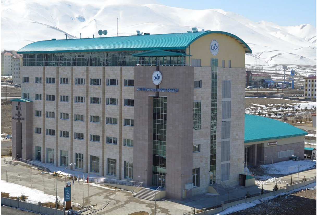
DAP İdaresi Hizmet Binası
