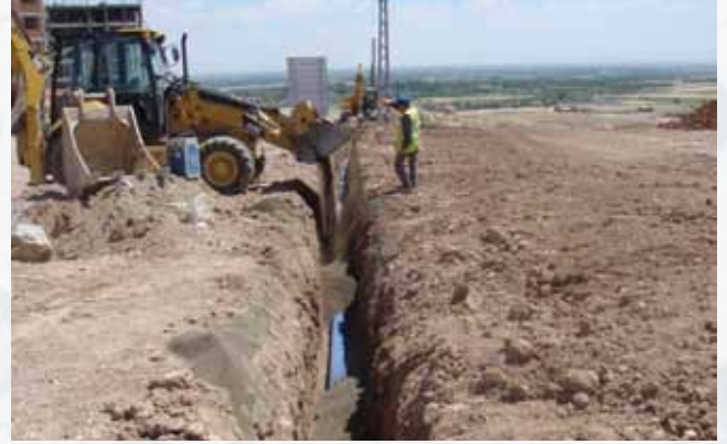
MERAM İLÇESİ YENİ SU ŞEBEKE TESİSİ VE ISLAHI İÇİN BORU, EK PARÇA TEMİNİ VE DÖŞEME İŞİ
