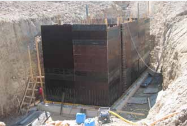
TERFİ İSTASYONU İNŞAATI YAPILMASI İŞİ
