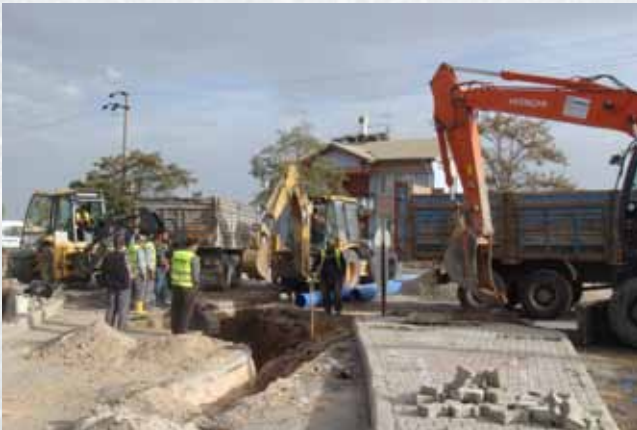
KARATAY İLÇESİ YENİ SU ŞEBEKE TESİSİ VE İSLAHI İÇİN BORU, EK PARÇA TEMİNİ VE DÖŞEME İŞİ
