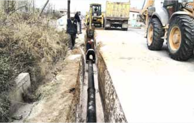
MUHTELİF ÇAPTA ÇELİK BORU VE DUKTİL DEMİR BORU TEMİNİ VE DÖŞEME İŞİ
