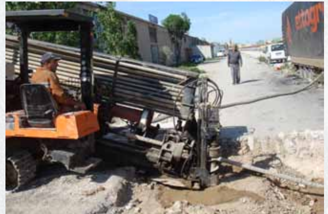
MUHTELİF CADDELERDE YATAY SONDAJ YÖNTEMİYLE TÜNEL AÇMA VE BORU DÖŞEME İŞİ
