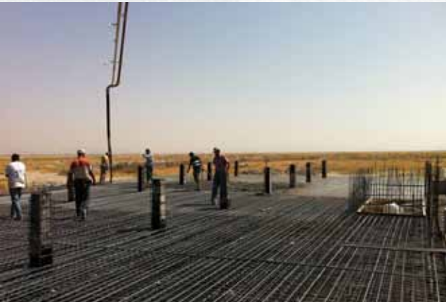
KONYA ATIKSU ARITMA TESİSLERİ İÇERİSİNE DEPO YAPILMASI İŞİ
