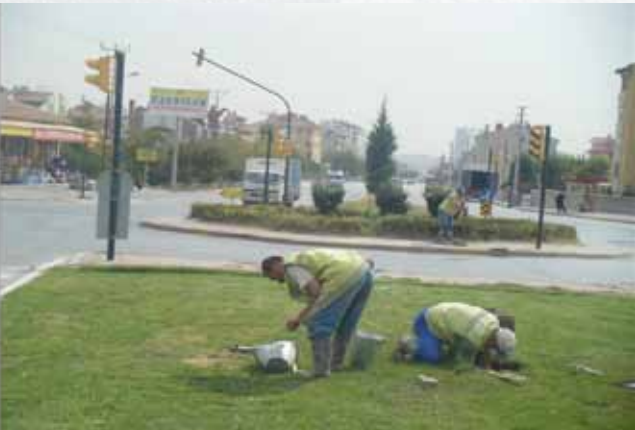
PARK, YEŞİL ALAN, HİDRANT VB. ARIZA ÇALIŞMALARI
