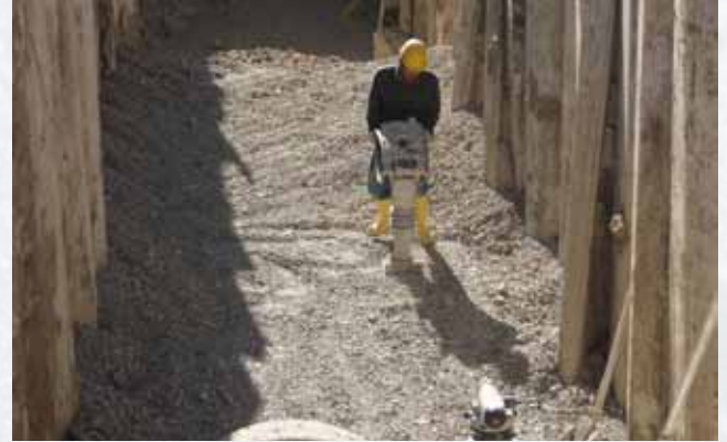
SARACOĞLU BÖLGESİ ANA KOLLEKTÖR HATTI DÖŞENMESİ İŞİ
