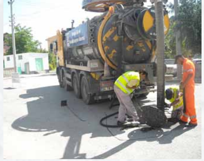
KANALİZASYON ŞEBEKESİ TEMİZLİK ÇALIŞMALARI
