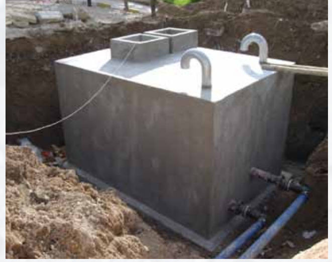
SONDAJ KUYUMUZ, GÖRÜNTÜ BOZUKLUĞU VE ÇEVRE KİRLİLİĞİNİ ÖNLEMELERİ AMACIYLA BETONARME KUYU KABİNİ İLE YER ALTINA ALINMIŞTIR.
