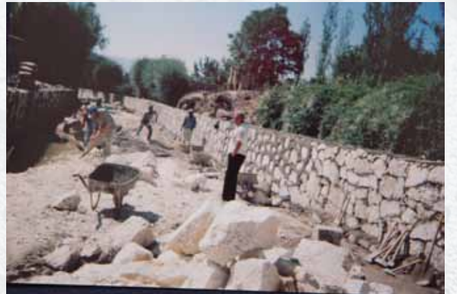
KÜÇÜK MUHSİNE KÖYÜ TAŞKIN KÖRUMA KANALI YAPIM İŞİ
