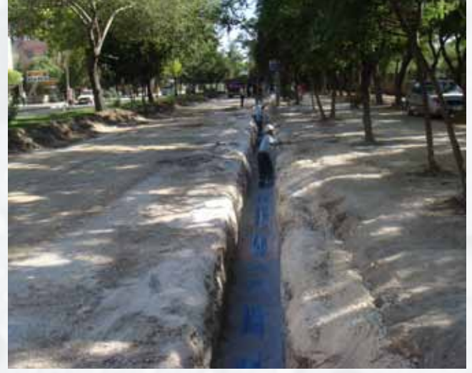
KONYA MERKEZ SU ŞEBEKE İSLAHI İÇİN BORU, EK PARÇA TEMİNİ VE DÖŞEME İŞİ,
