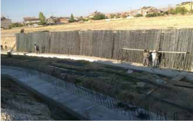
SELBASAN YAĞMUR SUYU UZAKLAŞTIRMA KANAL YAPIM İŞİ
