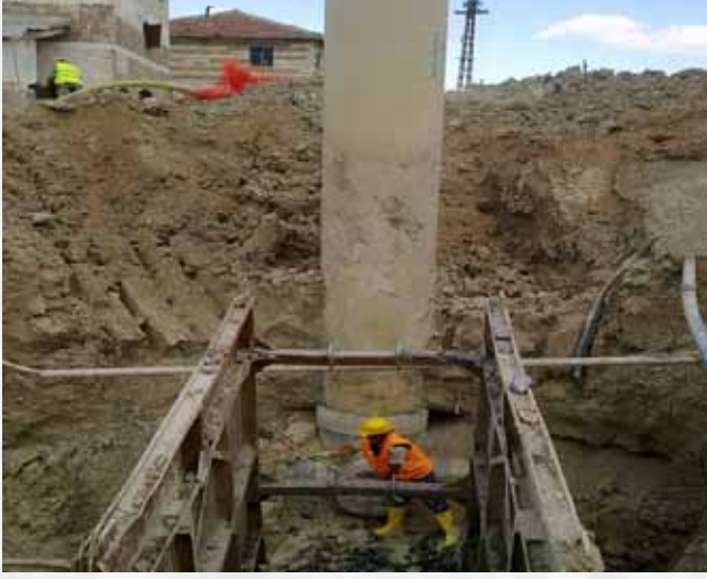
SARAÇOĞLU BÖLGESİ KANALİZASYON İNŞAATI
