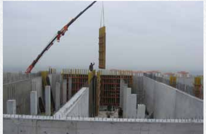
ÇARIKLAR 5000 M³ LÜK GÖMME SU DEPOSU İNŞAATI İŞİ
