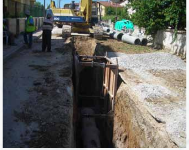
MERAM BÖLGESİ 1. KISIM KANAL ISLAH İNŞAATI
