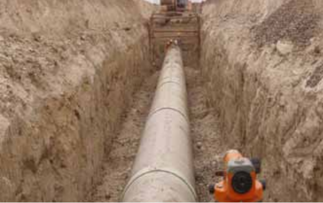
ALAKOVA BÖLGESİ ANA KOLLEKTÖR HATTI DÖŞENMESİ İŞİ
