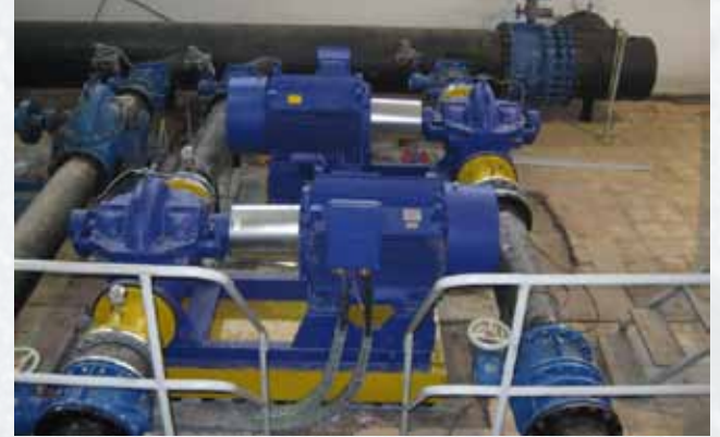
POMPA İSTASYONLARINA YENİ ALINAN POMPALARIN MONTAJLARI YAPILMIŞTIR
