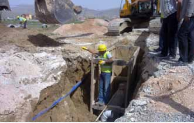
SELÇUKLU BÖLGESİ 1. KISIM KANAL ISLAH İNŞAATI
