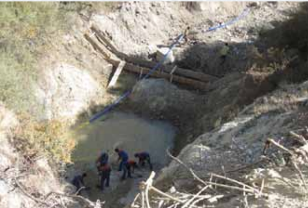
TATKÖY MAHALLESİ İKİ AYRI KAPTAJ (KAYNAK GELİŞTİRME) ÇALIŞMASI GERÇEKLEŞTİRİLMİŞTİR
