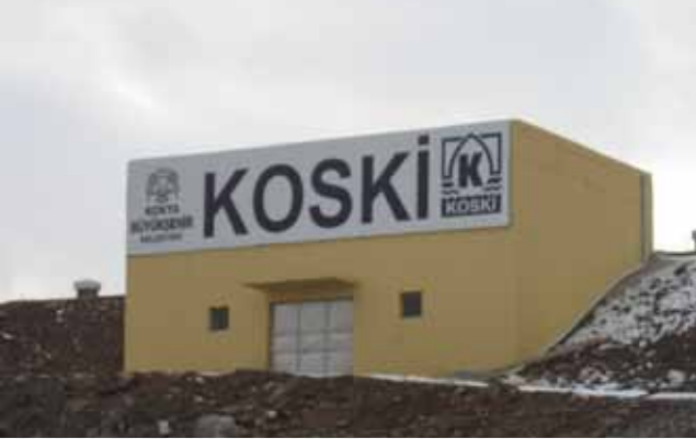
SULUTAS 500 M3 LUK GÖMME SU DEPOSU YAPILMASI İŞİ
