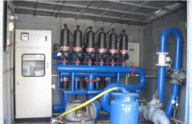
SONDAJ KUYULARINA FİLTRE TAKILARAK SU ŞEBEKESİNİN VE SU ABONELERİNİN EVSEL CİHAZLARIN ZARAR GÖRME RİSKİ ÖNLENMİŞTİR
