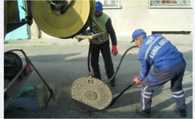
KANAL AÇMA ARAÇLARI İLE YAPILAN ÇALIŞMALAR
