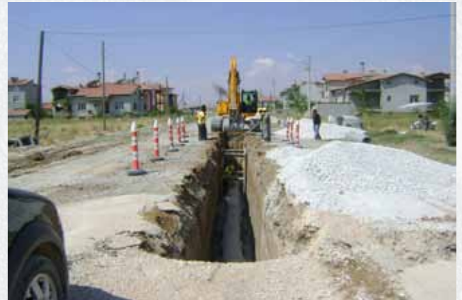
ALAKOVA-TATLILAK BÖLGESİ KANALİZASYON İÇ ŞEBEKE İNŞAATI
