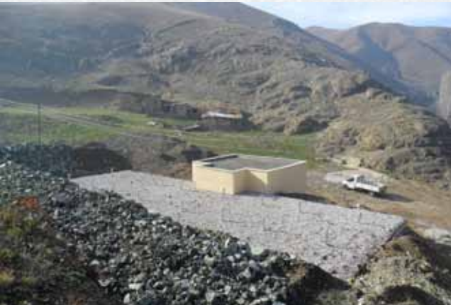
BEYPINARI 1000 M³ LÜK GÖMME SU DEPOSU İNŞAAT İŞİ
