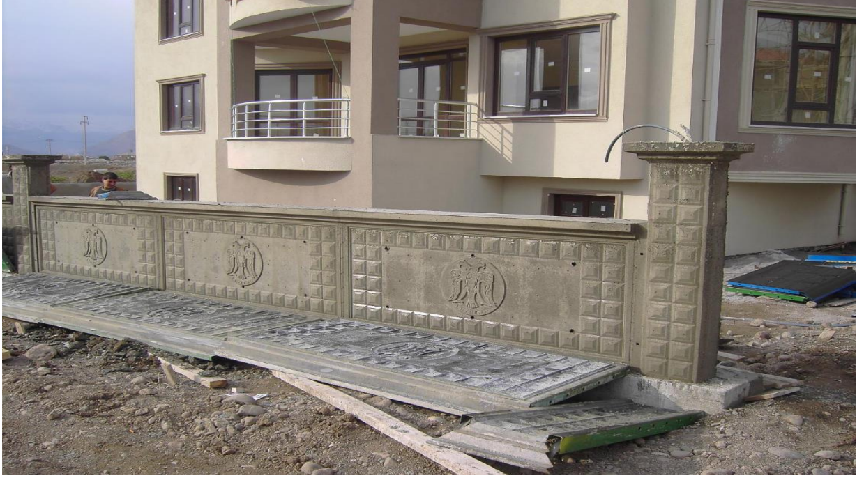
Bahçe duvarları yapımı
