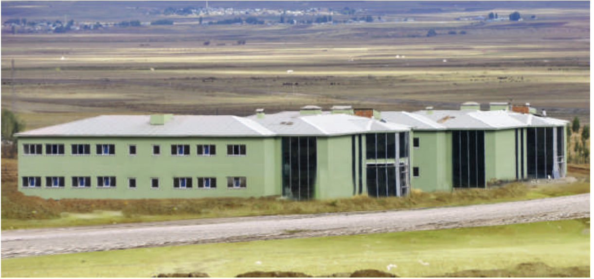
Resim 9. Yapımı Devam Eden Merkezi Araştırma Laboratuvarı Binası
