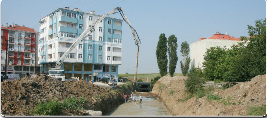
Fotoğraf 11: Atatürk Mahallesi Dere Islah Çalışması (02 Ağustos 2010)
