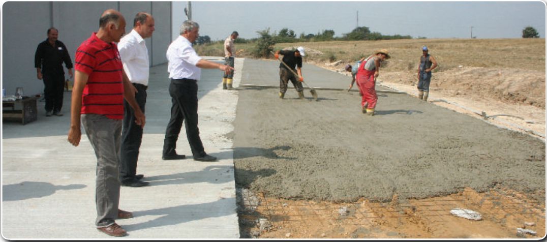
Fotoğraf 12: Yeni Sanayi Beton Yol Çalışması (03 Ağustos 2010)
