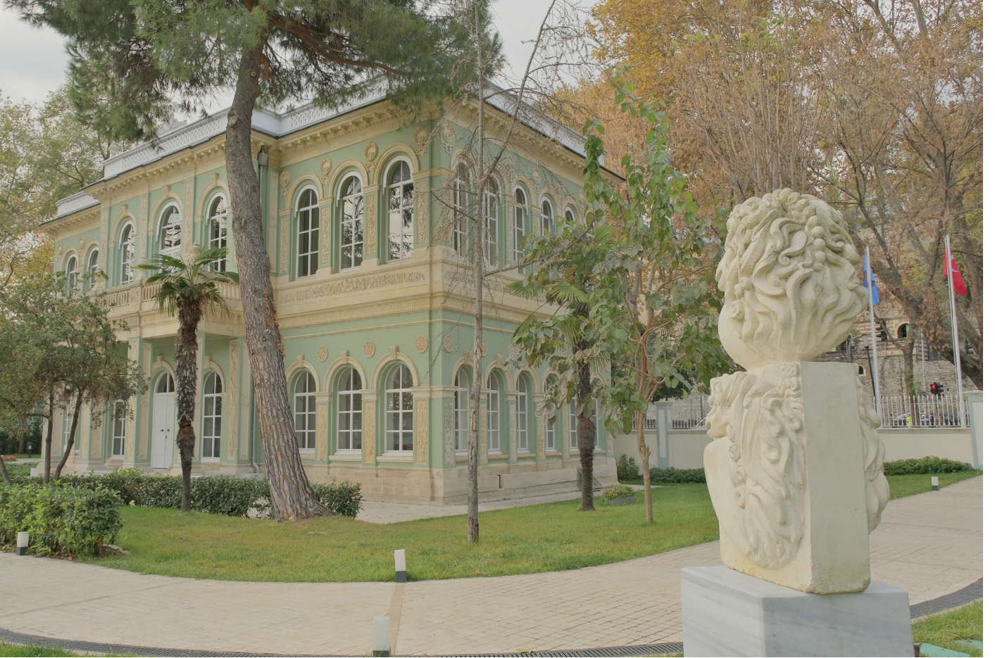
Restorasyonu tamamlanan Tophane Kasrı
