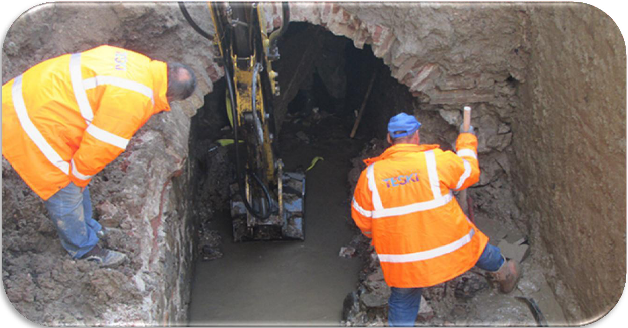
Resim 3: Tekirdağ Süleymanpaşa İlçesi Yağmur Suyu Menfezi Bakımı Onarımı
