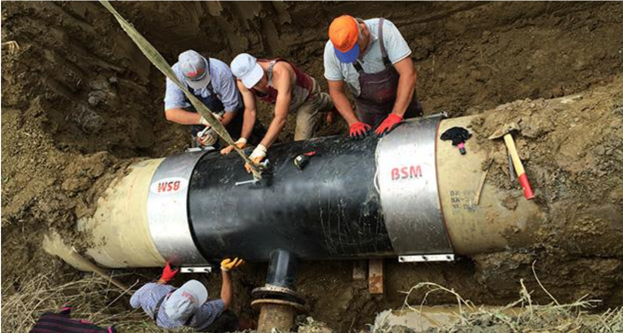
Resim 2: İçme Suyu Arızası Onarımı
