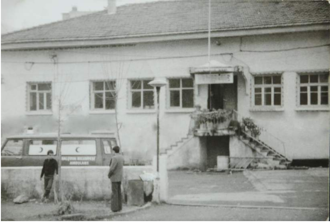
Resim 3: Balçova Belediyesi İlk Hizmet Binası
