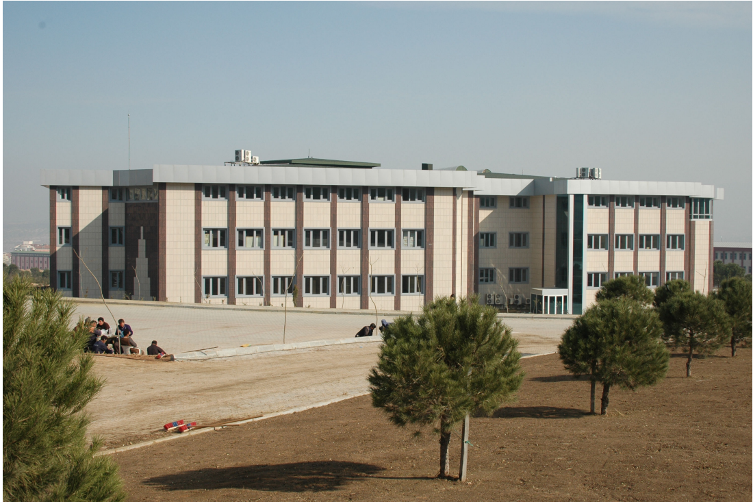
Rektörlük binası güney cephesinin genel görünümü
