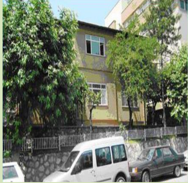
Eski Hizmet Binası
