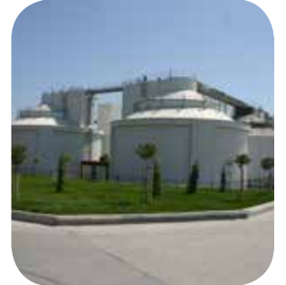
İleri Biyolojik Atık Su Arıtma Tesisleri / Arıtma Üniteleri
